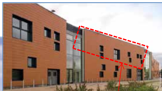
L'edificio dell'incubatore di impresa: lato nord (sopra) e lato sud (a sinistra). Il riquadro tratteggiato indica il piano occupato da ISTEC
